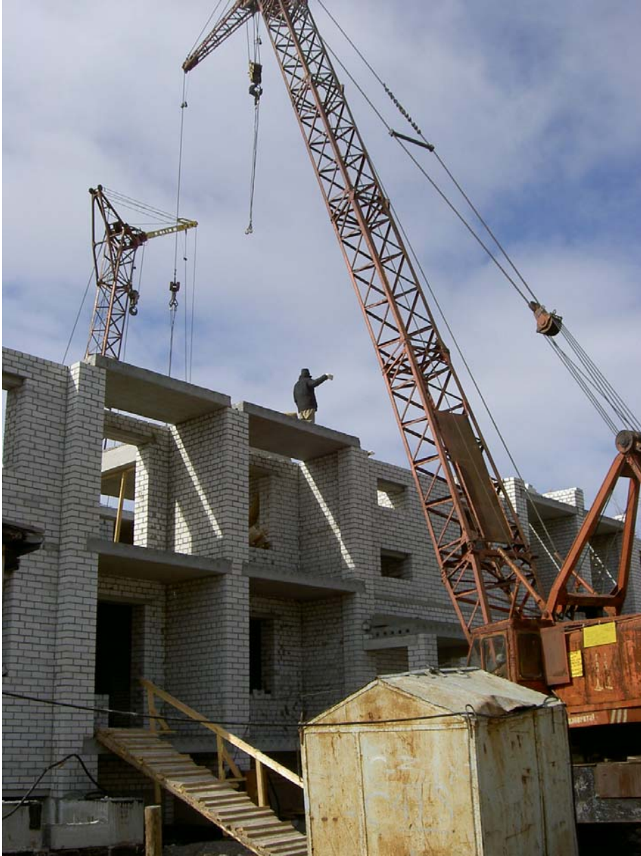
Kuva 2. Uusien suurten (noin 160 m 2 :n huoneistoja) asuntojen rakentamista Severodvinskissa 4/2004. Vahvat tiilirakenteiset massiivisen muurit, joissa on ulkoseinissä 100 mm:n mineraalivillaeristys molemmin puolin muovilla "suojattuna". Muurien vahvuus on "perinteisen" vahva. Perusteluna tälle on, että suunnittelija on määritellyt rakenteen. Tarvetta suunnitteluosaamiselle?
