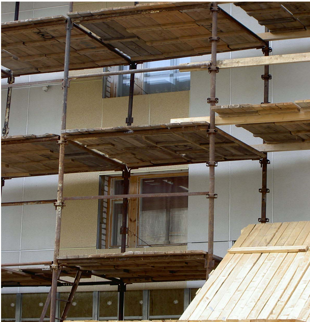
Kuva 3. Vanhan kerrostalokiinteistön ulkoseinien lisälämmöneristysten toteuttamista Severodvinskissä 4/2004. Muurattuun tiiliseinään kiinnitetään 100 mm:n mineraalivilla sekä ohutpellistä valmistetut kiinnikkeet kivimurskepintaisen julkisivulevyn kiinnittämiseksi. Ilmarako noin 50 mm. Rakenteen hinta on noin 300 €/m 2 . Tekniikka ja materiaalit ovat Ukrainasta.
